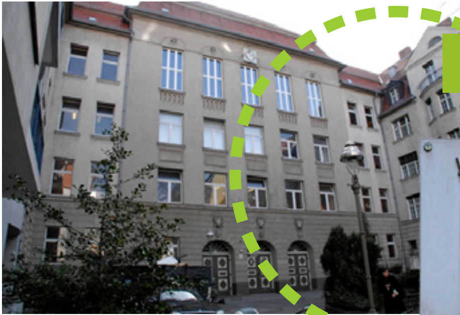
Auf den ersten Blick unscheinbar: Das Hauptgebäude der Albert-Schweitzer-Schule in Neukölln
